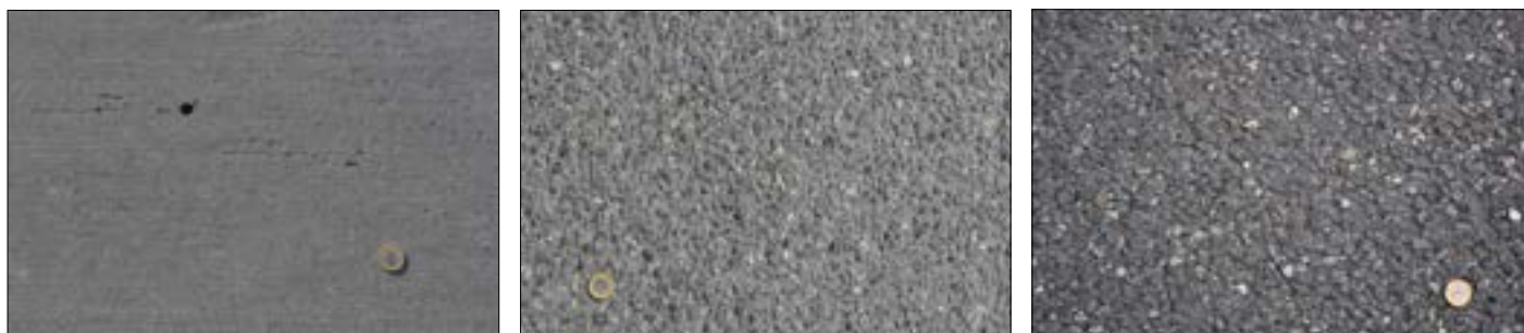
Rys. 2. Widok przykładowych nawierzchni różniących się pod względem hałaśliwości
